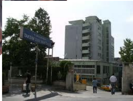
Önde 7 katlı blok
