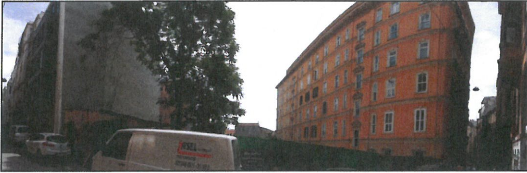
Şekil 3.44: Serdar-ı Ekrem Caddesi üzerinden Doğan Apartmanı kuzeydoğu cephesi ve 58 parsel sayılı taşınmazın görünümü, 2016
