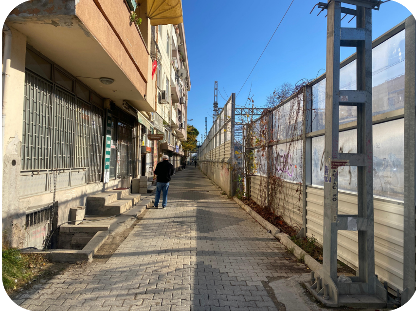
GÖRSEL 37. ÇİLİNGİR SOKAK BİNA VE MARMARAY DUVARI YÜZEYLERİNİN GÖRÜNÜMÜ
