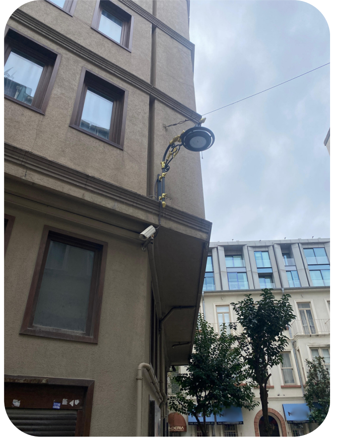
GÖRSEL 44. KUYUMCU İRFAN SOKAK, NİŞANTAŞI, ŞİŞLİ. TRAFİĞE KAPALI SOKAKTA BİNA YÜZEYİ ARMATÜR KULLANIMI
