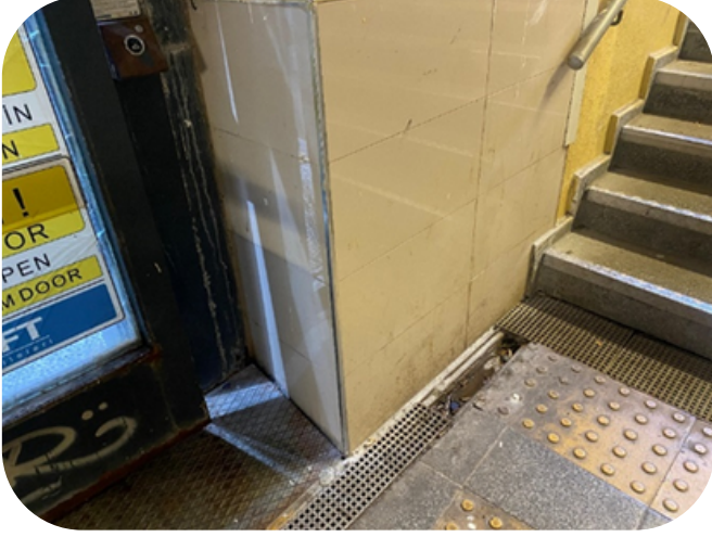
GÖRSEL 11. YAĞMUR SUYU KANALI
