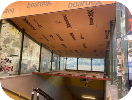
GÖRSEL 10. ALT GEÇİT GİRİŞ KISMI TAVAN ARMATÜR EKSİKLİĞİ
