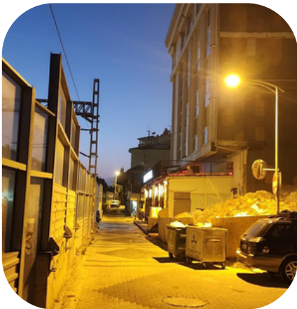
GÖRSEL 28. ÇİLİNGİR SOKAK KASIM 2024 İNŞAAT ALANI ÖNÜNDE BULUNAN AYDINLATMA ARMATÜRÜ
