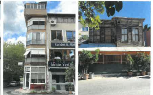
Kaçak yapılaşma, cephe oranlarının bozulması. Tescilli yapıların bakımsızlığı.
