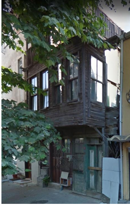
Şekil 2-142: Zemin Katın Paravanla Kapatılmadan Önceki Hali
