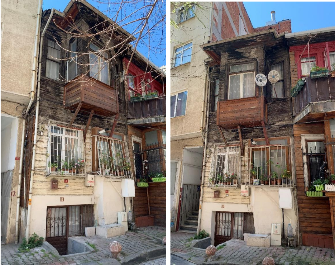
Şekil 2-56: Yapının Genel Görünüşü
