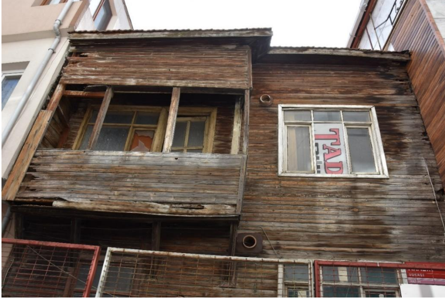
Şekil 2-177: Yapının Birinci Katı
