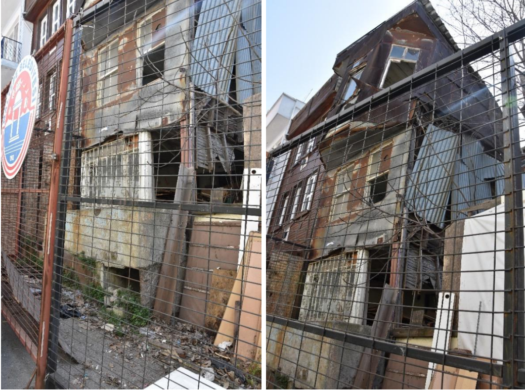
Şekil 2-117: Yapının Genel Görünüşü
