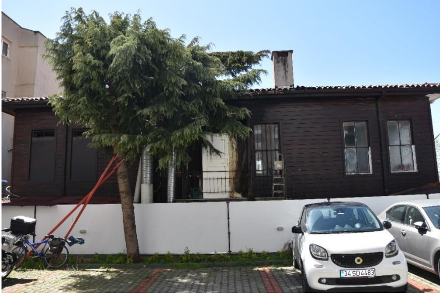
Şekil 2-67: Yapının Günümüzdeki Arka Cephe Fotoğrafı
