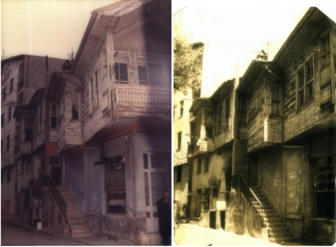
Şekil 2-104: Binanın Restorasyon Önceki Küçükalyalı Caddesi Cephesi
