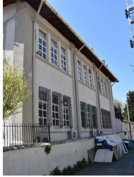
Şekil 2-184: Yapının Yan Cephesi
