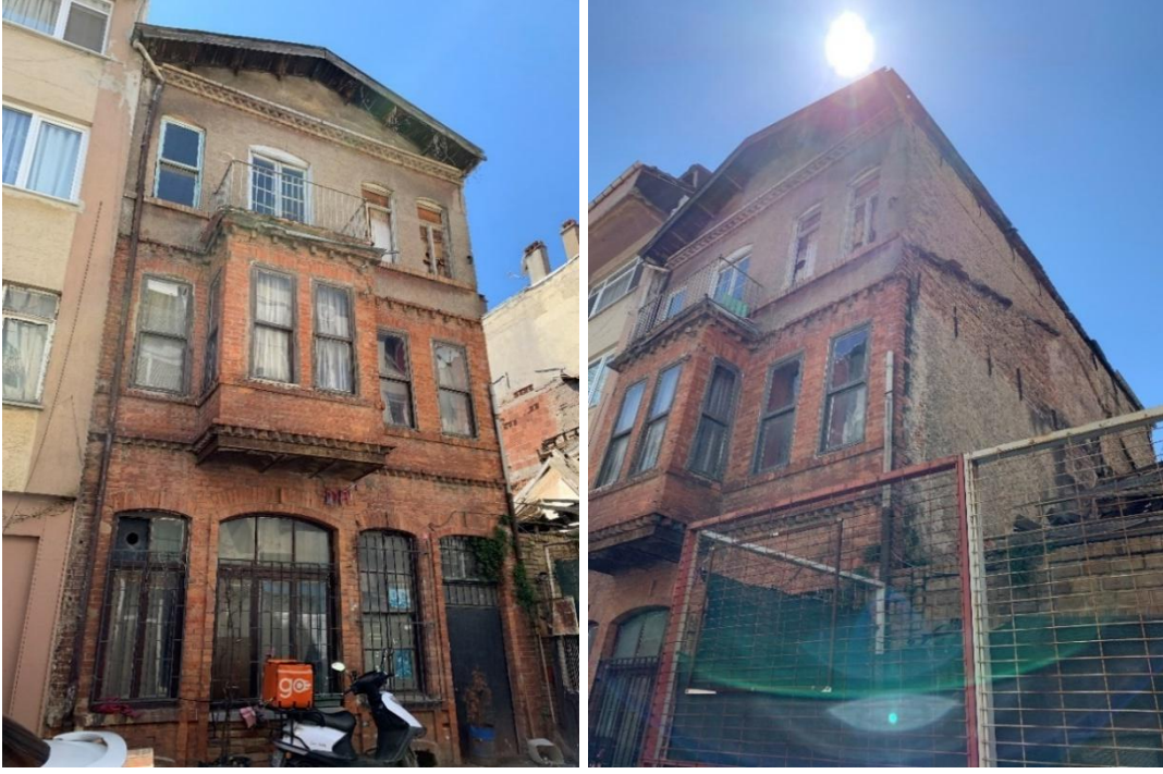
Şekil 2-46: Binanın Genel Görünüşü
