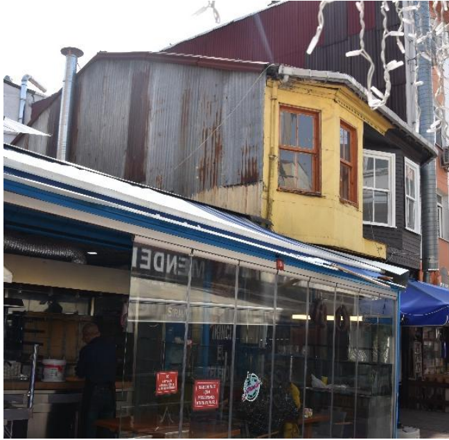
Şekil 2-86: Yapının Genel Görünüşü
