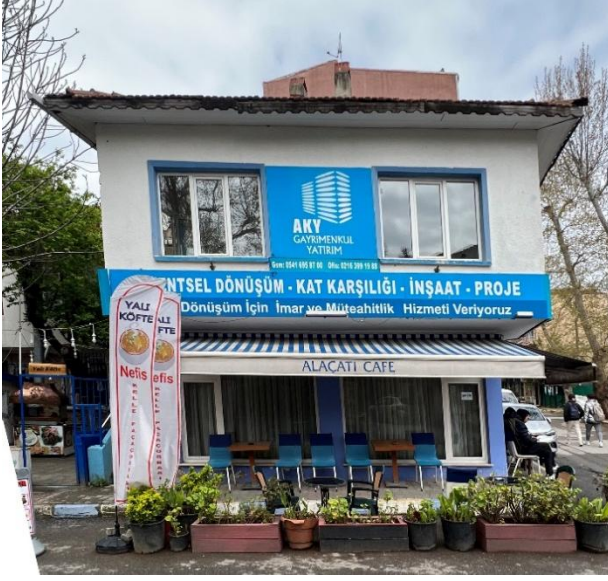
Şekil 2-150: Kagir Yapının Sokak Cephesi
