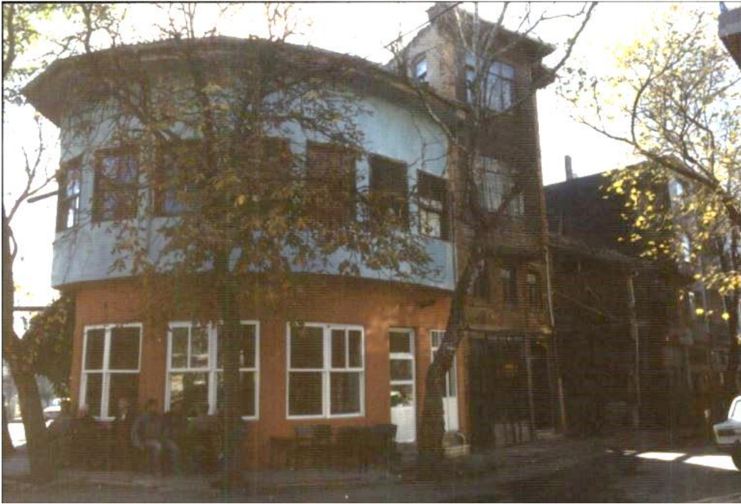
Şekil 2-92: Yapının Kış Bahçesi Yapılmadan Önceki Fotoğrafi
