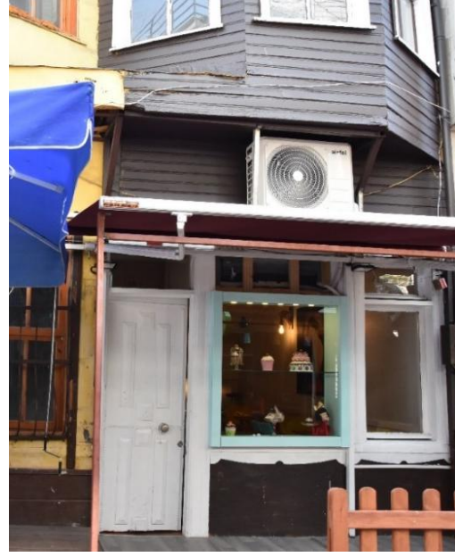
Şekil 2-84: Yapının Zemin Katı
