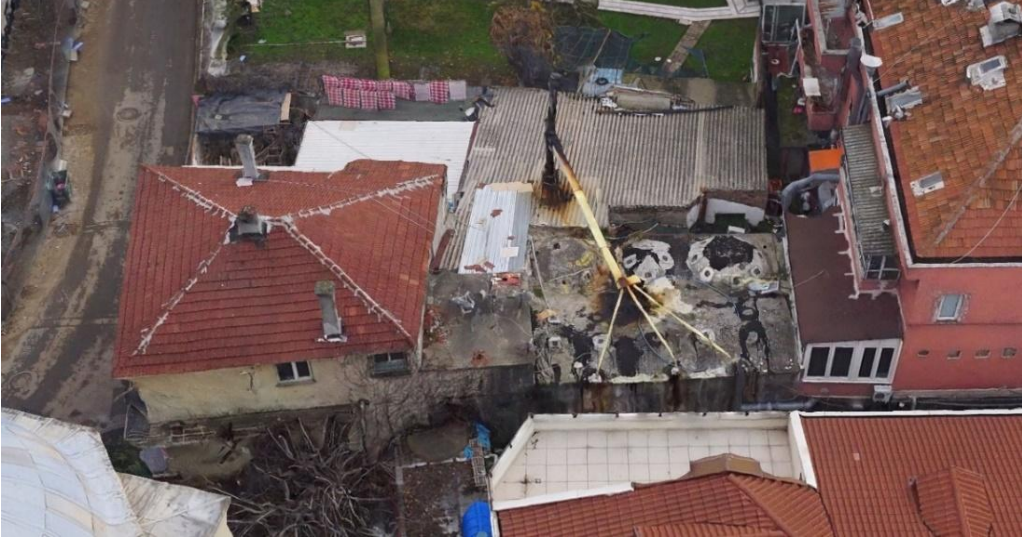
Şekil 2-186: Hamamın Genel Görünüşü
