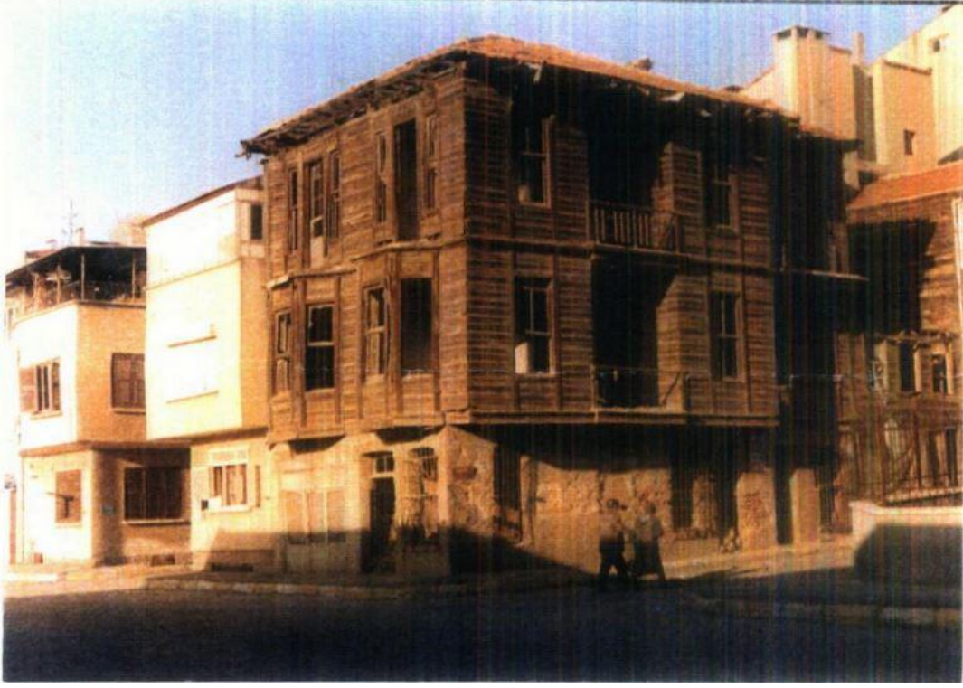
Şekil 2-70: Yapının Yıkılmadan Önceki Genel Görünüşü
