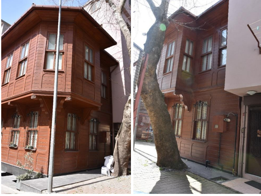
Şekil 2-133: Aralık Sokak Cephesi
