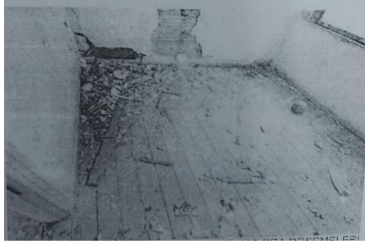
Şekil 2-130: Özgün yapının üst kat oda döşemeleri
