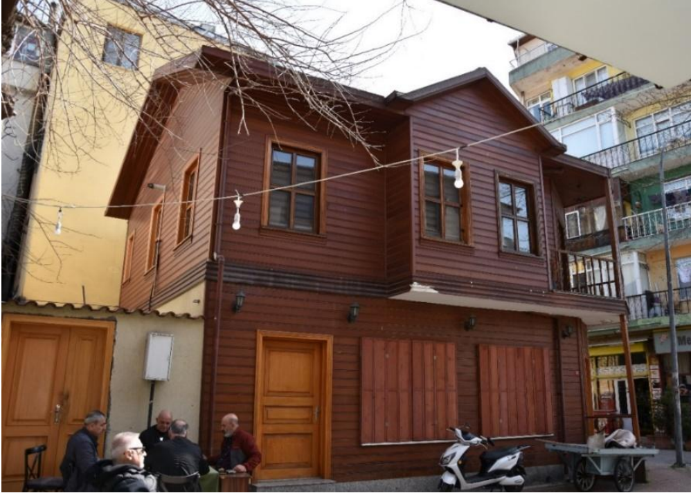
Şekil 2-135: Yapının Günümüzdeki Ön Cephesi
