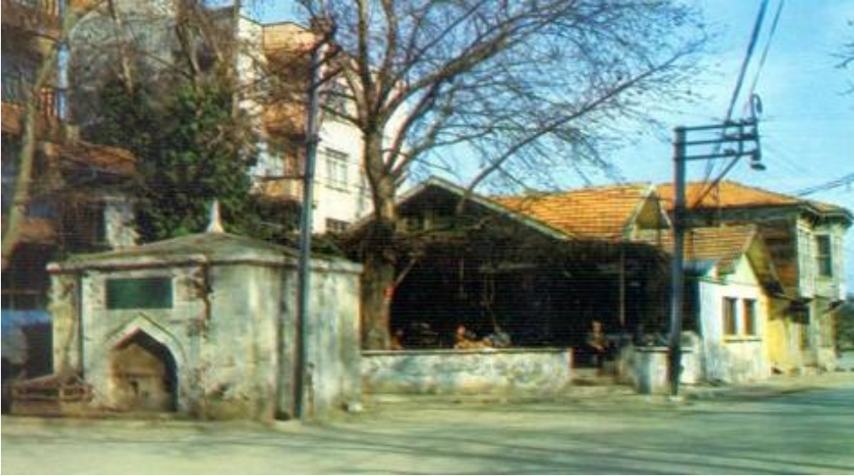
Şekil 2-23: Çeşmenin Restorasyon Öncesi Fotoğrafi ( https://www.maltepe.com.tr )
