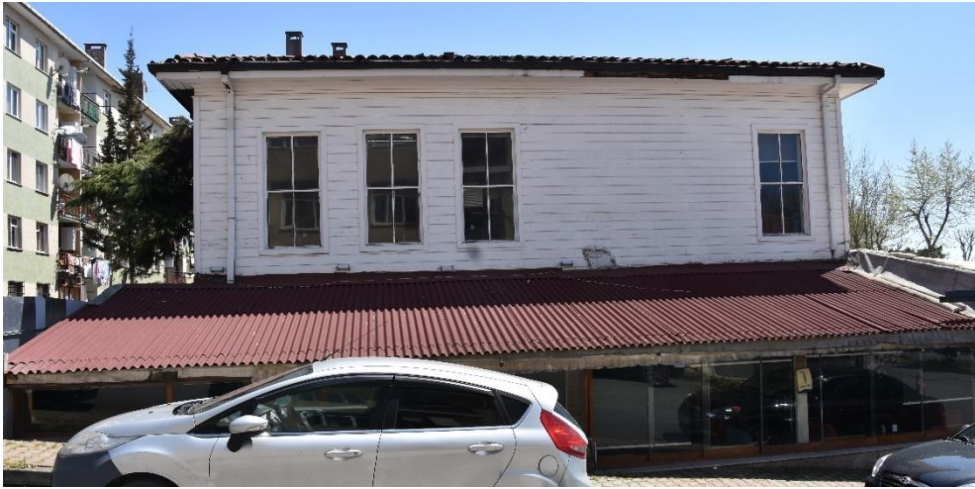
Şekil 2-66: Yapının Günümüzdeki Yan Cephe Fotoğrafi
