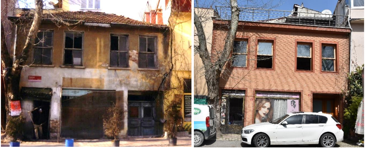
Şekil 2-112: Yapının Ön Cephesinin Eski Ve Yeni Fotoğrafi
