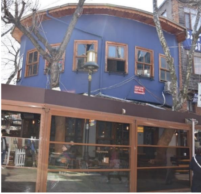
Şekil 2-93: Yapının Genel Görünümü
