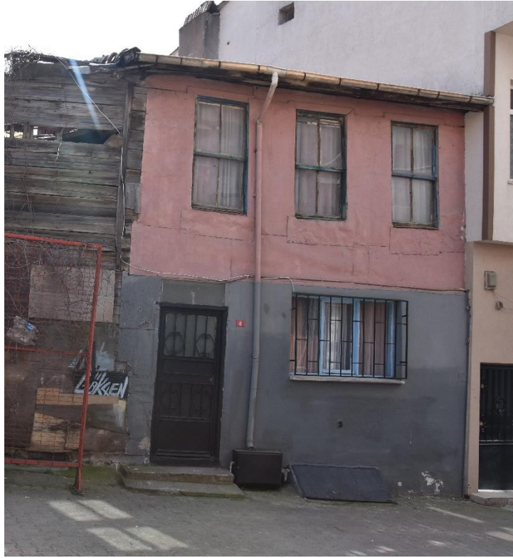
Şekil 2-181: Yapının Ara Sokak Cephesi
