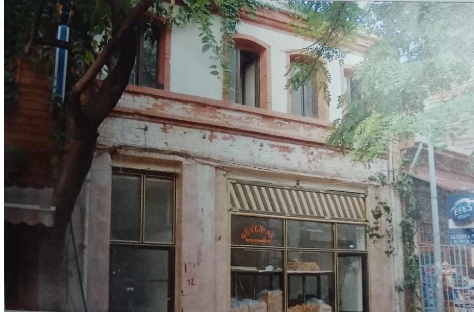
Şekil 2-99: Yapının Eski Fotoğrafi
