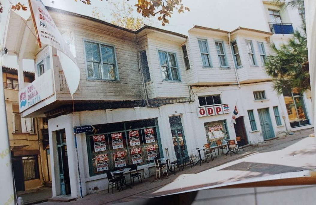
Şekil 2-107: Binanın Restorasyon Önceki Beşçeşmeler Sokak Cephesi
