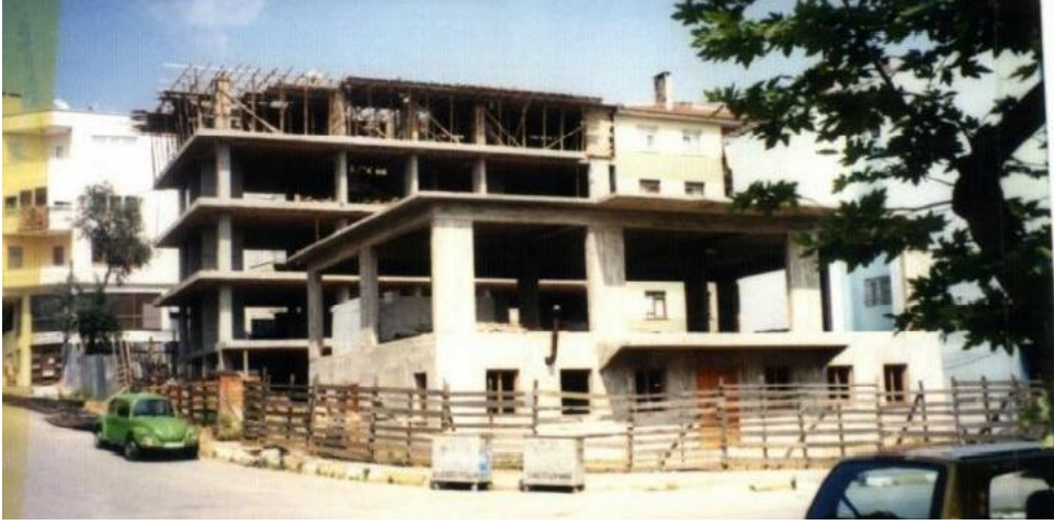
Şekil 2-64: Yapının Yenilenen Betonarme İnşaatı
