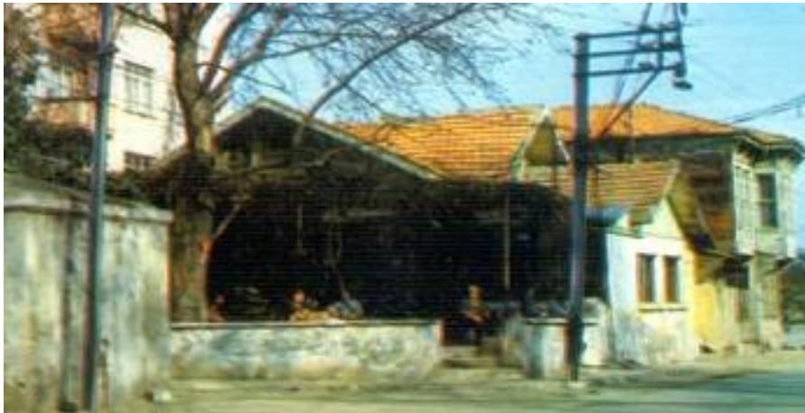
Şekil 2-169: Yapının Genel Görünümü
