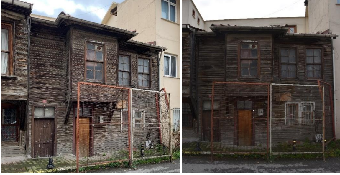
Şekil 2-152: Yapının Genel Görünüşü
