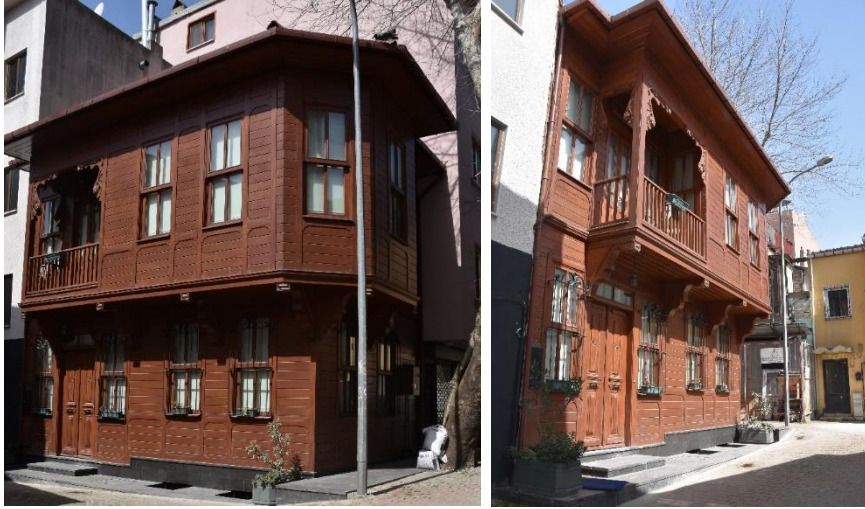
Şekil 2-132: Ara Sokak Cephesi
