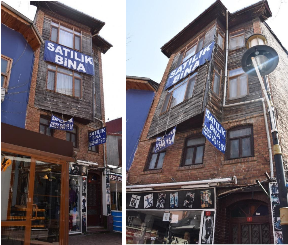
Şekil 2-89: Yapının Genel Görünüşü
