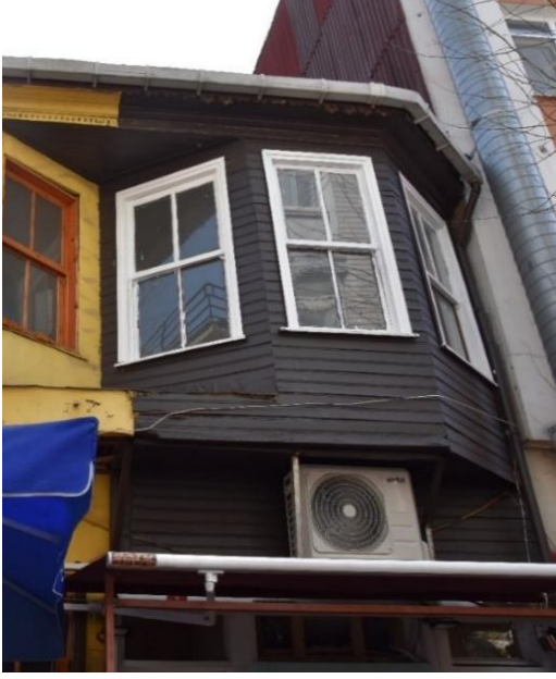
Şekil 2-83: Yapının Birinci Katı
