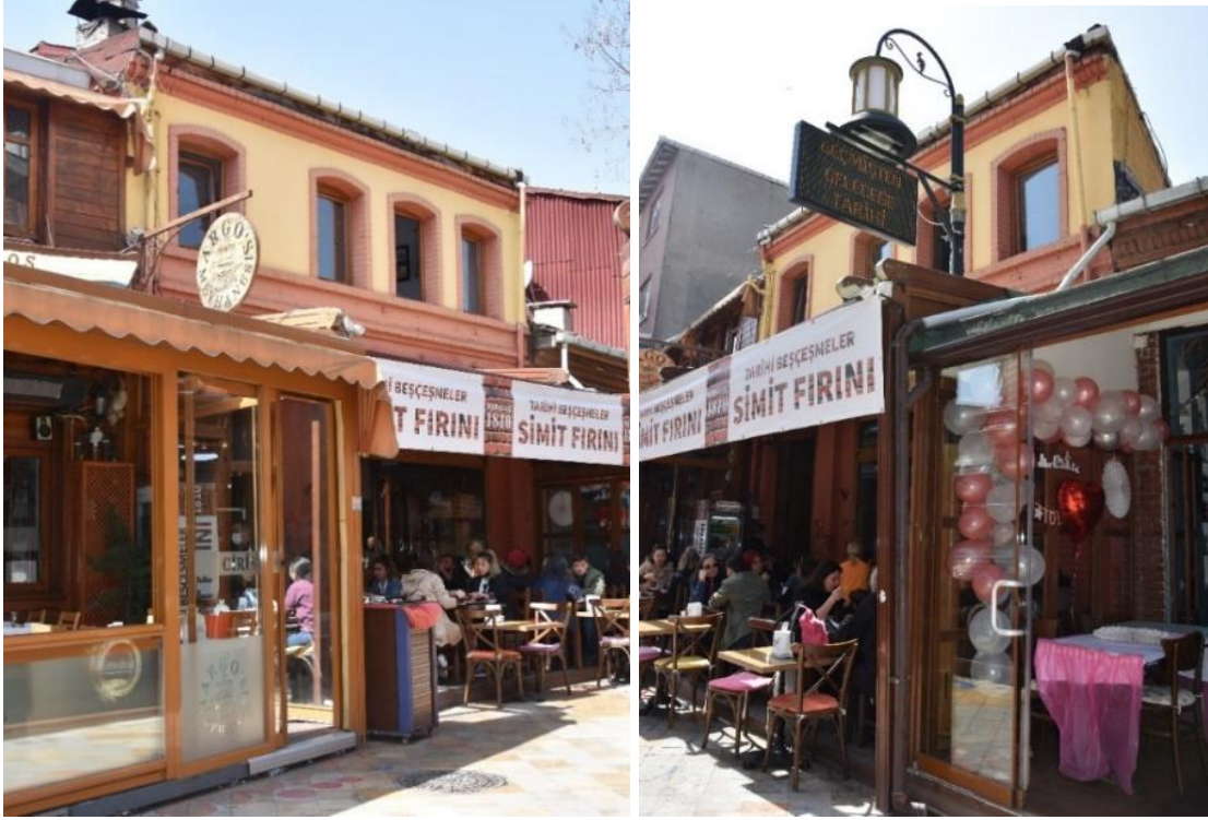
Şekil 2-100: Yapının Genel Görünüşü
