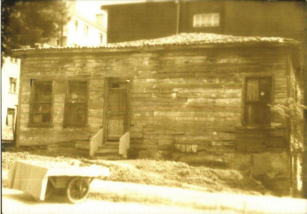
Şekil 2-61: Yapının Yan Cephesi-1992
