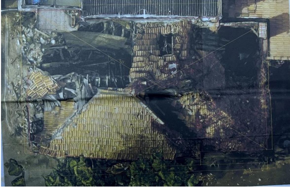
Şekil 2-74: Yapının Kıрма Çatısı
