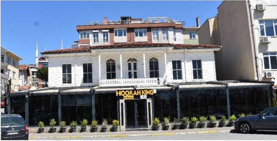
Şekil 2-65: Yapının Günümüzdeki Ön Cephe Fotoğrafi
