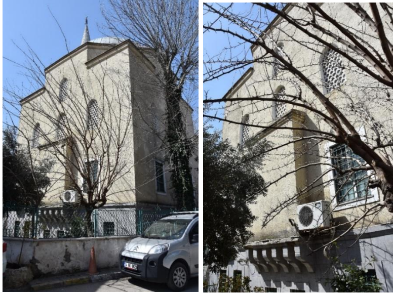
Şekil 2-175: Caminin Mihrap Cephesi
