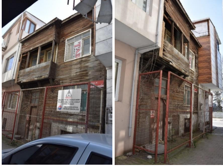
Şekil 2-176: Yapının Genel Görünüşü
