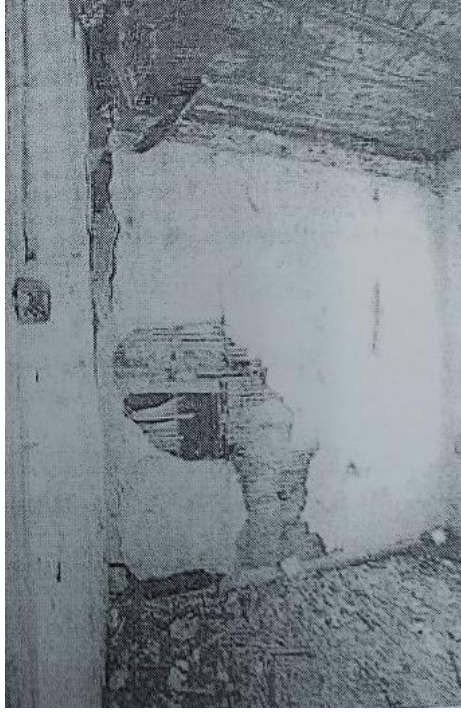
Şekil 2-131: Özgün Yapının Üst Kat Tavan Ve Oda Döşemeleri
