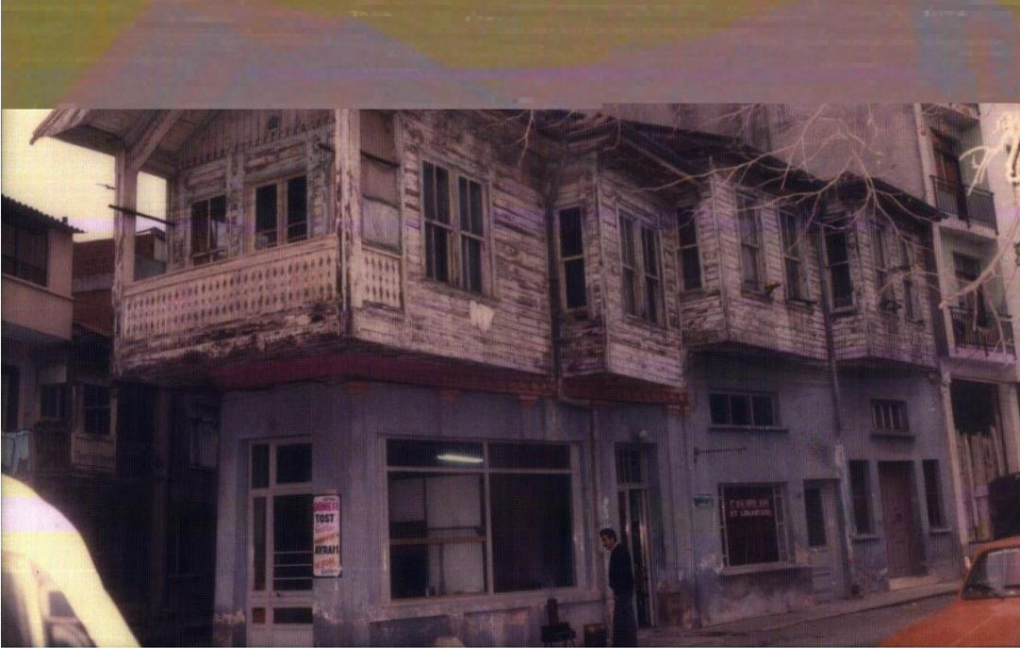
Şekil 2-102: Binanın Restorasyon Önceki Beşçeşmeler Sokak Cephesi
