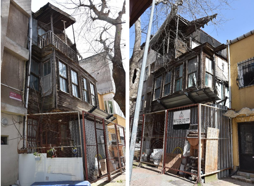
Şekil 2-143: Yapının Genel Görünüşü
