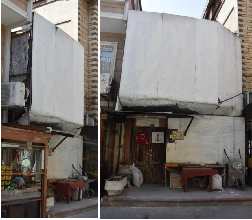
Şekil 2-118: Yapı Etrafının Sac İle Kapatılmış Hali
