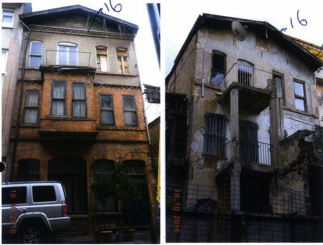
řekil 2-45: Yapının 2016 Tarihli n Ve Arka Cephe Fotođrafı
