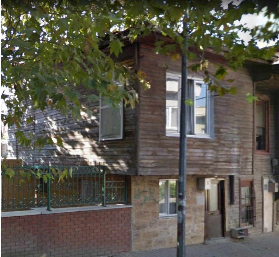
Şekil 2-156: Yapının Genel Görünümü
