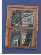
Orta çitallı ahşap giyotin pencere Ada: 16514 Parsel: 12
