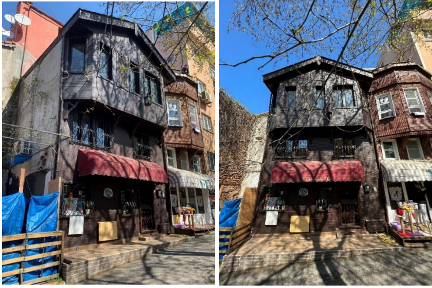
Şekil 2-79: Yapının Genel Görünümü
