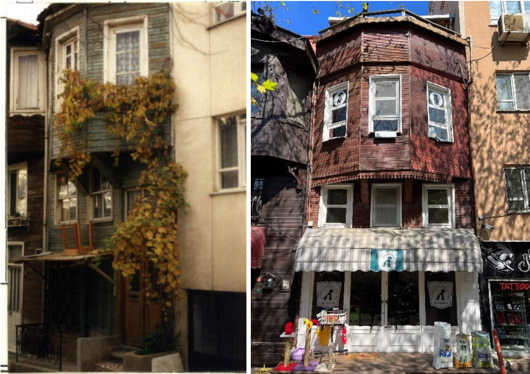
Şekil 2-77: Fırın Sokak Cephesi Eski Ve Yeni Fotoğraf
