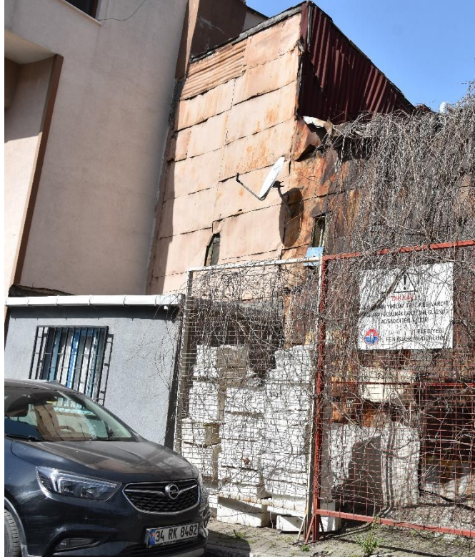
Şekil 2-182: Yapının Fevziye Sokak Cephesi
