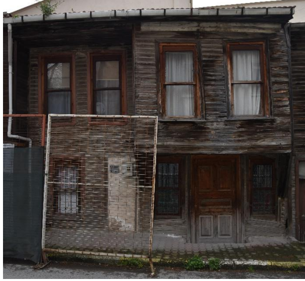
Şekil 2-153: Yapının Genel Görünüşü
