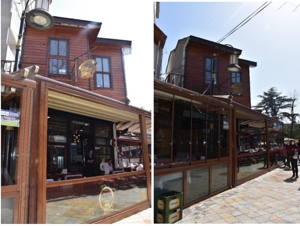
Şekil 2-54: Yapının Yan Cephesi
