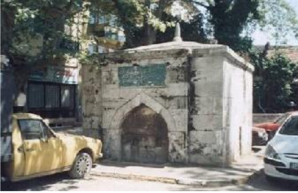
Şekil 2-22: Çeşmenin Restorasyon Öncesi Fotoğrafi ( http://www.suvakfi.org.tr )
