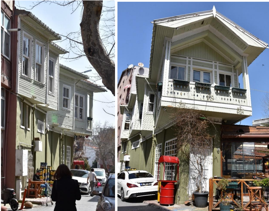
Şekil 2-109: Yapıdaki Gönye Çıkımlar
