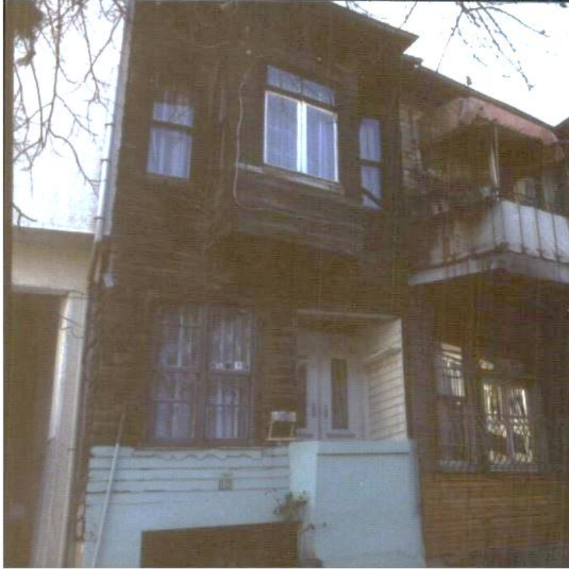
Şekil 2-55: Yapının Balkon Bölümü Kapatılmadan Önceki Hali
