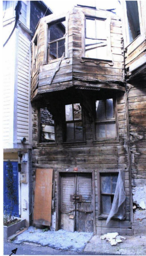
Şekil 2-124: Bina Yıkılmadan Önceki Hali
