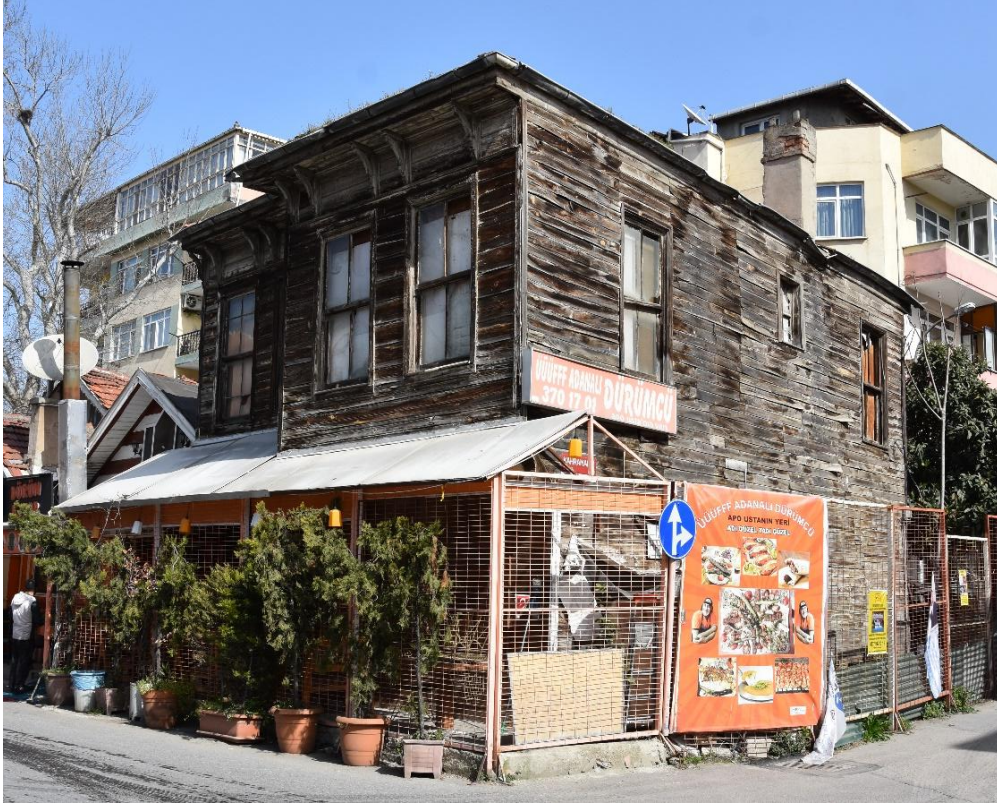
Şekil 2-163: Binanın Ön Ve Yan Cephesi
