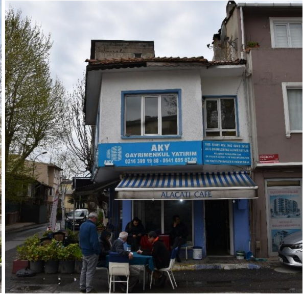
Şekil 2-151: Kagir Yapının Cadde Cephesi
