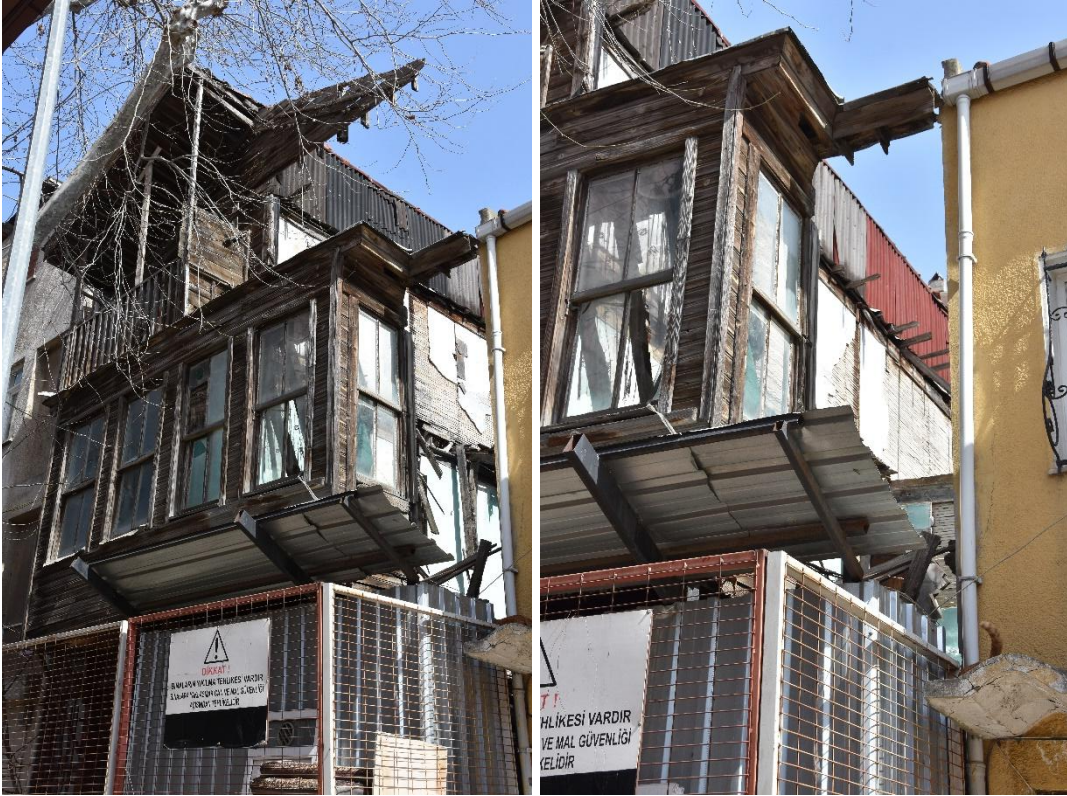
Şekil 2-145: Binanın Yıkılan Bölümleri
