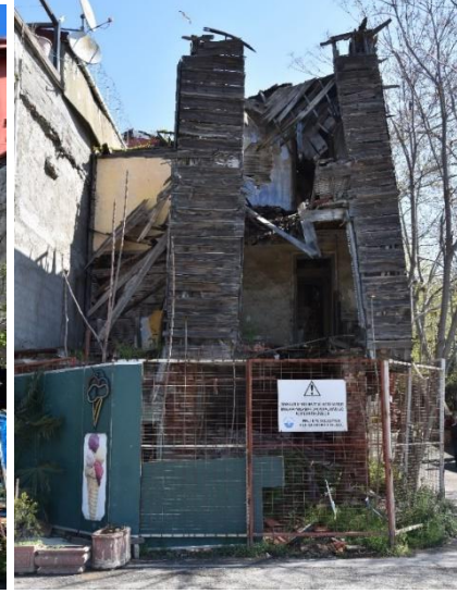
Şekil 2-73: Yapının Yan Cephesi
