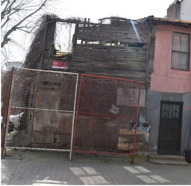
Şekil 2-179: Yapının Ara Sokak Cephesi
