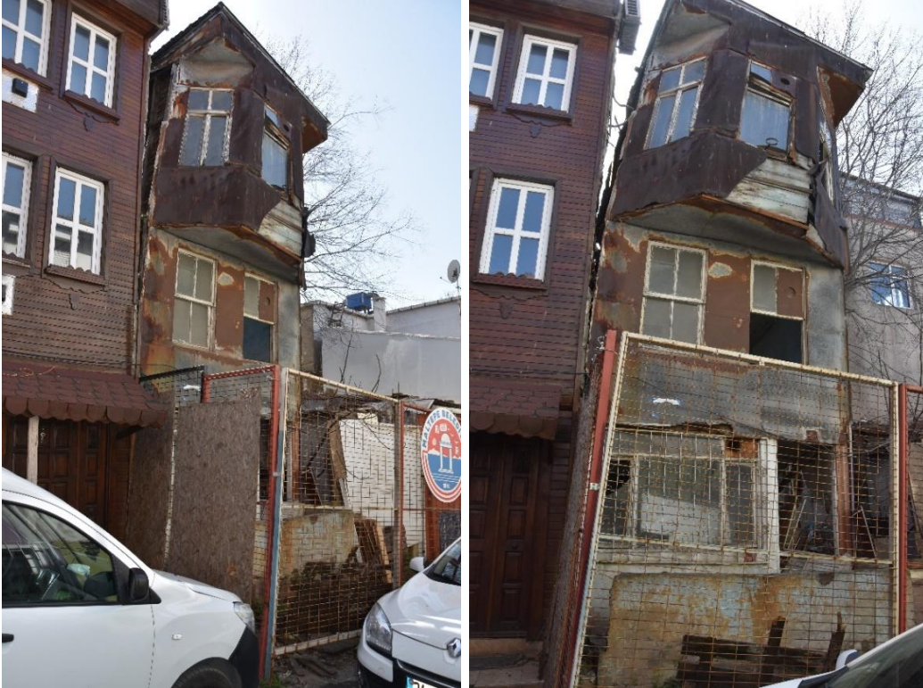
Şekil 2-116: Yapının Genel Görünüşü
