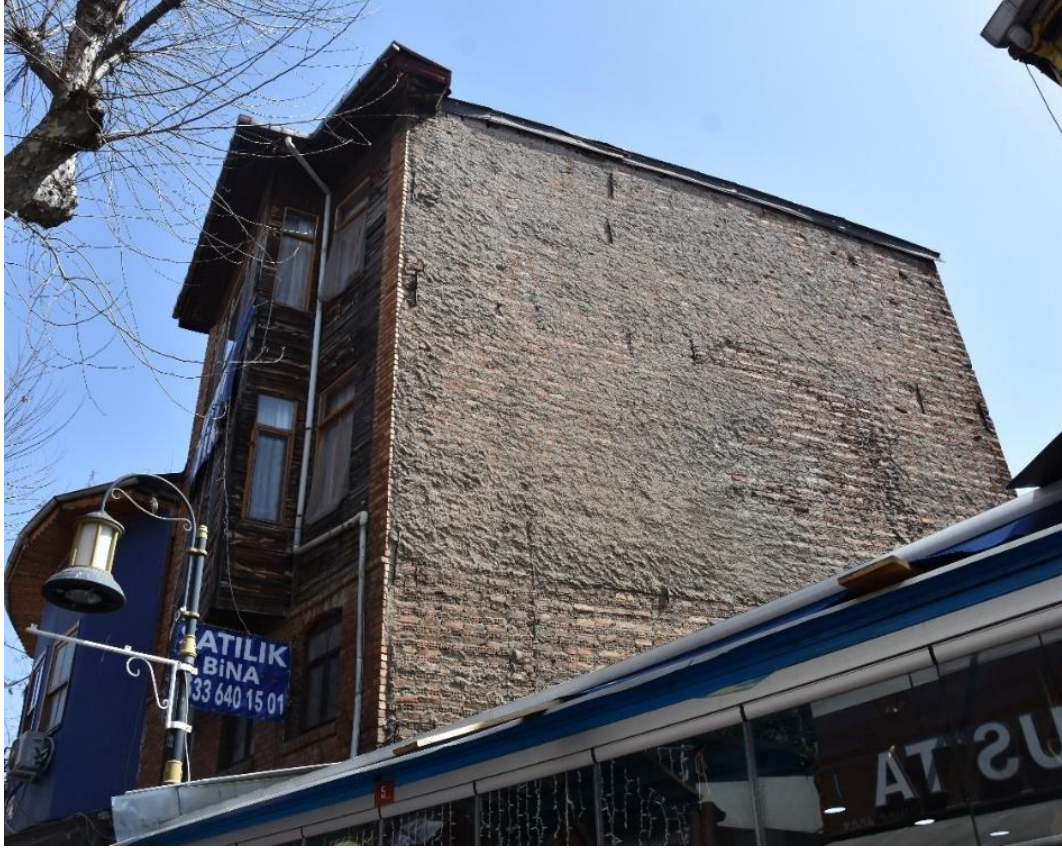
Şekil 2-91: Binanın Yan Cephesi
