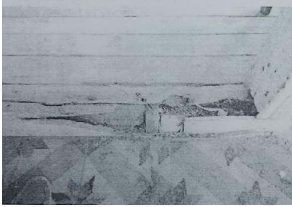
Şekil 2-129: Özgün Yapının Zemin Kat Taşlık Ve Oda Döşemeleri
