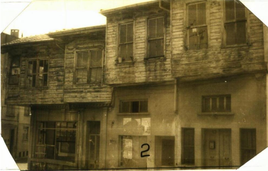
Şekil 2-103: Binanın Restorasyon Önceki Beşçeşmeler Sokak Cephesi
