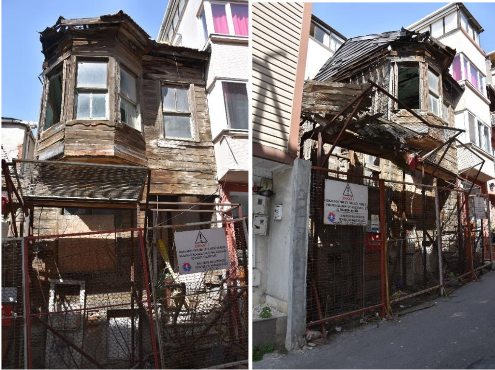
Şekil 2-122: Yapının Genel Görünüşü
