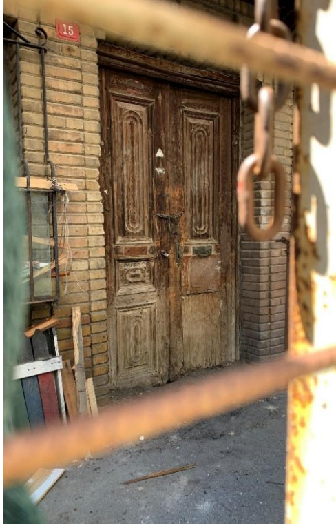
Şekil 2-42: Sağ Tarafda Yer Alan Kapı
