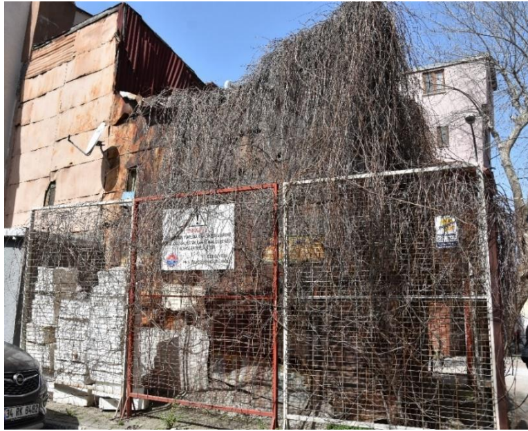
Şekil 2-180: Yapının Fevziye Sokak Cephesi
