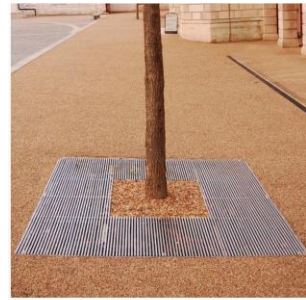
Ağaç köklerinin çevresinde sert zemin uygulaması yapılmamalı, ağaçların çevresinde min. 90 cm yumuşak zemin boşluk bırakılmalıdır. Ağaçların kaldırım kenarında olması durumunda dikilik ile kaldırım bordürü arasında 20 cm mesafe olmalıdır.
