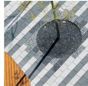
Ağaç köklerinin çevresinde sert zemin uygulaması yapılmamalı, ağaçların çevresinde min. 90 cm yumuşak zemin boşluk bırakılmalıdır. Ağaçların kaldırım kenarında olması durumunda dikilik ile kaldırım bordürü arasında 20 cm mesafe olmalıdır.
