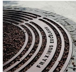
Ağaç köklerinin çevresinde sert zemin uygulaması yapılmamalı, ağaçların çevresinde min. 90 cm yumuşak zemin boşluk bırakılmalıdır. Ağaçların kaldırım kenarında olması durumunda dikilik ile kaldırım bordürü arasında 20 cm mesafe olmalıdır.
